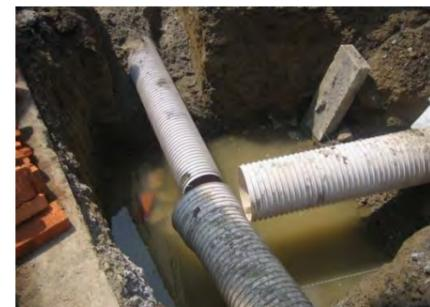
图 6.1-14 雨污分流改造
