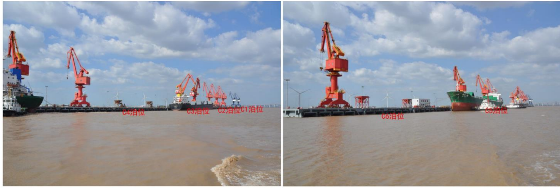
图 2.6-3 海盐港区 C 区岸线码头照片
