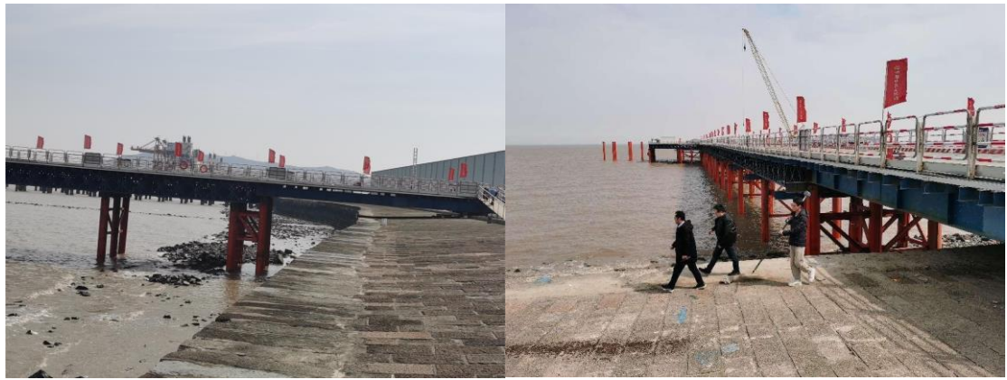
图 1.5-3 本项目现状照片
