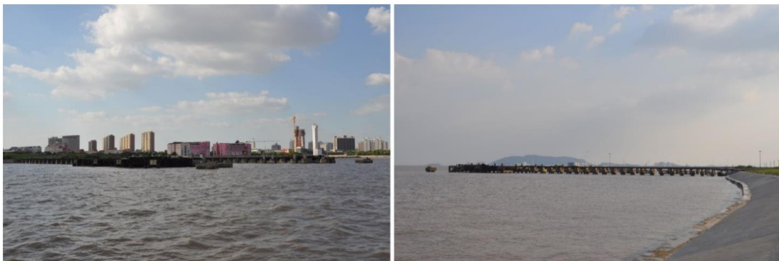
图 2.6-4 杭州湾跨海大桥箱梁出运码头
