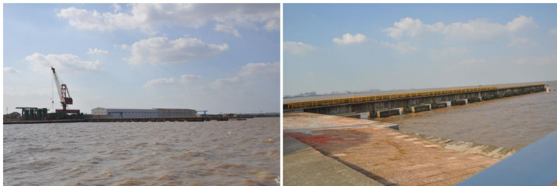
图 2.6-8 杭州湾跨海大桥墩身出运码头
