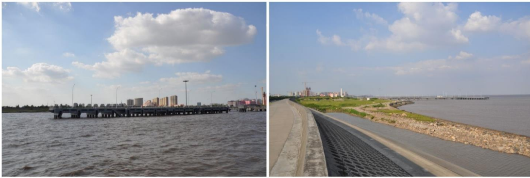
图 2.6-6 宁波航标处嘉兴港航标作业码头
