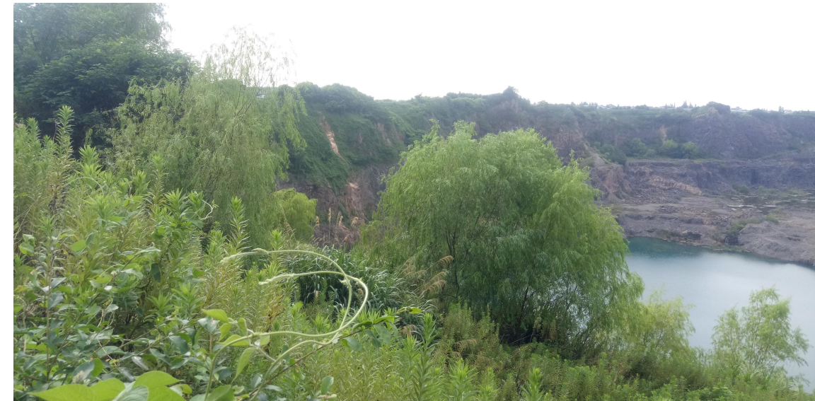
照片 3-2 II 区边坡现状远景
