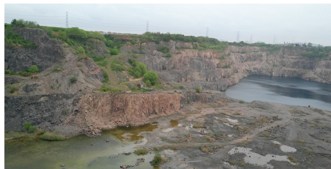
照片 3-1 I 区边坡现状远景
