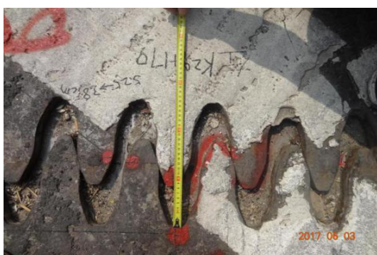
图 A. 1. 2-1 横向齿板错位抵死
