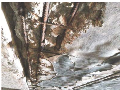
图 2.3.1-2 板底钢筋锈胀、混凝土剥落 图 2.3.1-3 钢筋锈胀、混凝土剥落
