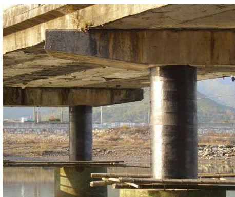
照 3.4.2-2 立柱粘贴碳纤维布加固
