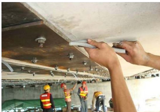
图 3.1.3-4 安装排气管
