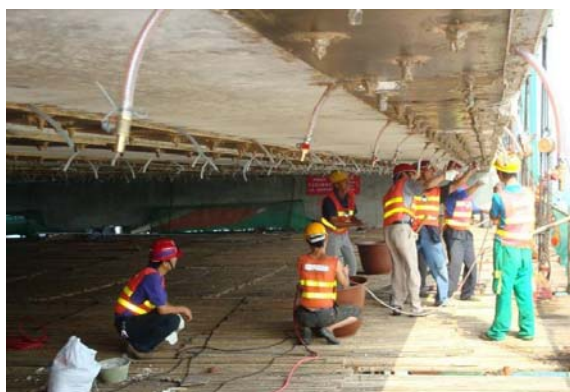
图 3.1.3-6 注胶施工
