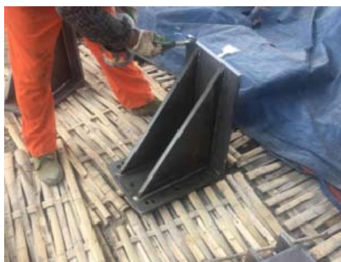
图 A. 2. 2-5 反力架涂装
