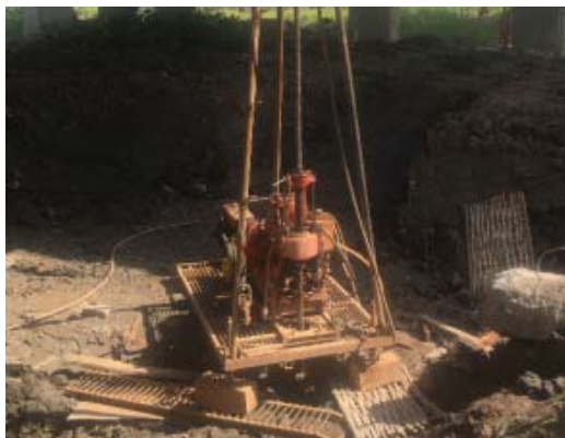
图 A. 2. 2-1 应力消散孔施工
