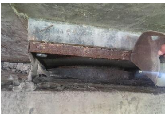
图 4.2.1-3 支座锈蚀
