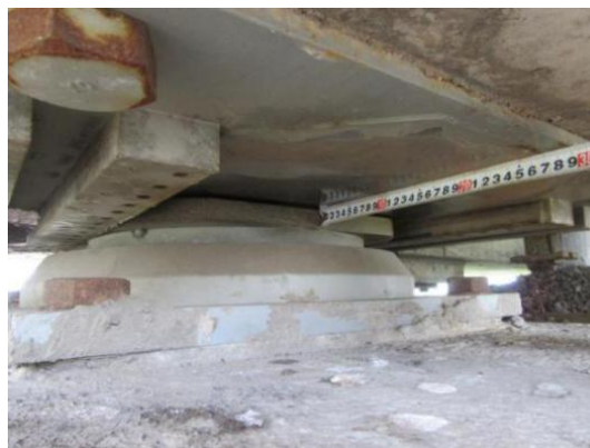
图 A.1.2-12 A 匝道 33#墩支座滑移 5.0cm
