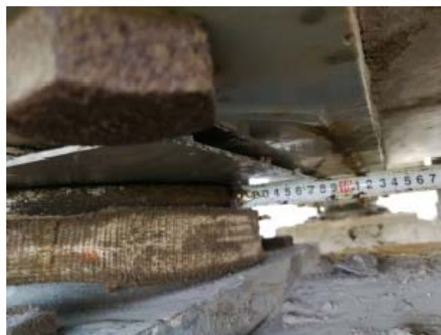
图 A. 2. 2-6 滑移面安装
