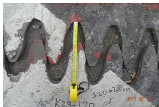
图 A. 1. 2-2 横向齿板错位抵死
