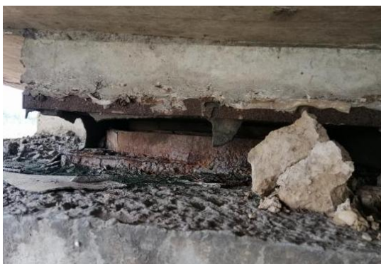
图 4.2.1-1 支座锈蚀
