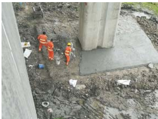
图 A. 2. 2-3 基础硬化施工
