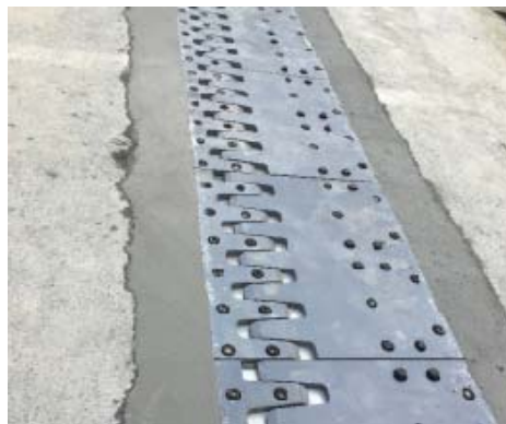
图 A. 2. 2-17 伸缩缝浇筑
