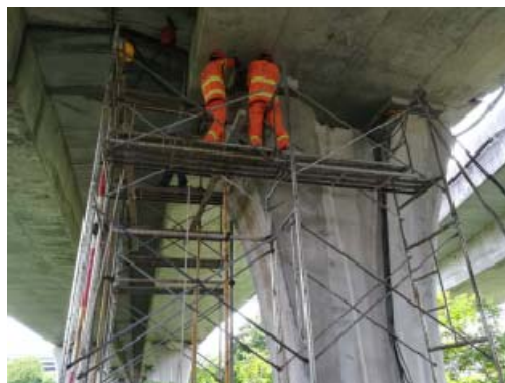
图 A. 2. 2-15 支座更换
