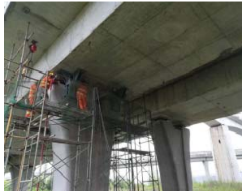
图 A. 2. 2-6 反力架安装
