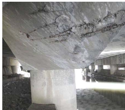
图 2.3.1-2 板底钢筋锈胀、混凝土剥落 图 2.3.1-3 钢筋锈胀、混凝土剥落
