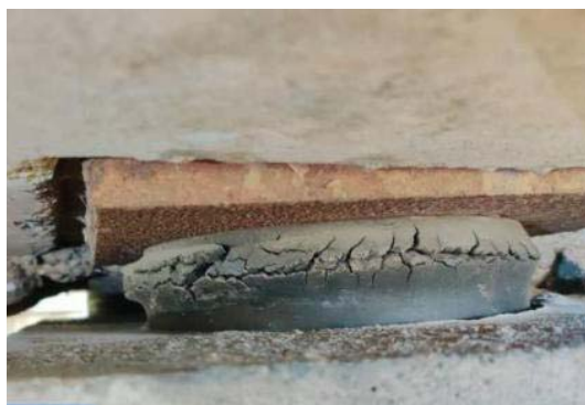
图 4.1.1-2 支座老化
