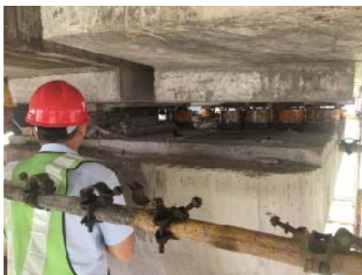
图 A. 2. 2-14 梁板顶升
