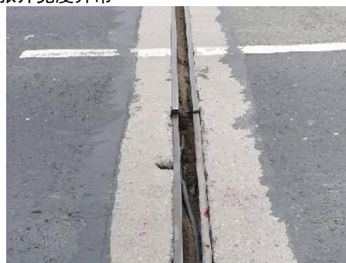
(b) 橡胶条皮损、型钢变形
