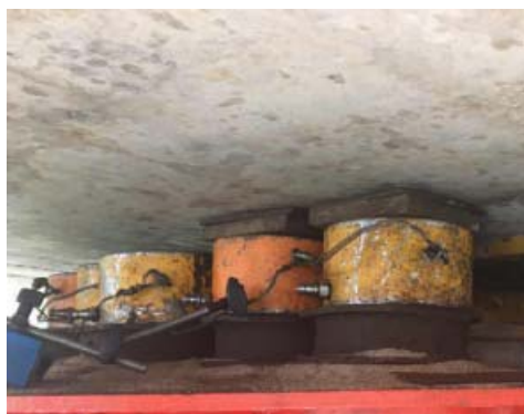
图 A. 2. 2-5 梁体顶升
