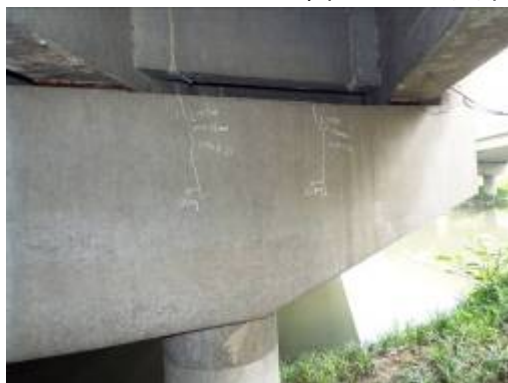
图 3.1.1-2 盖梁、台帽桩柱顶竖向、斜向裂缝
