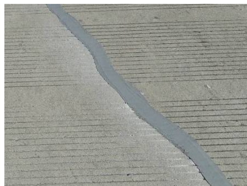
图 5.1.1-3 混凝土桥面裂缝封闭
