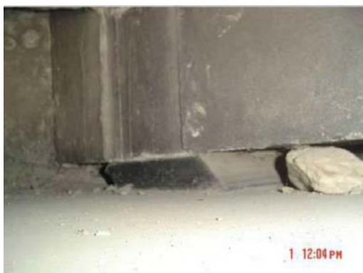
图 6.1.1-1 支座剪切变形
