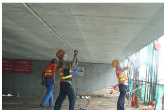
图 3.1.3-1 粘贴面表面处理
