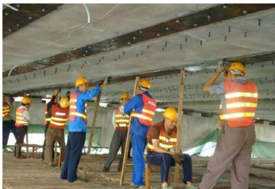
图 3.1.3-3 安装钢板
