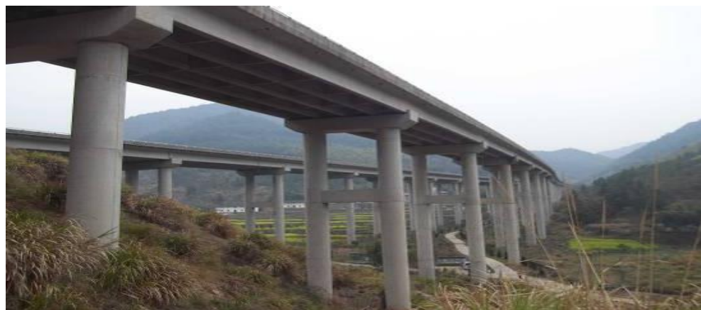
图 6-3 上下部结构联动偏位
