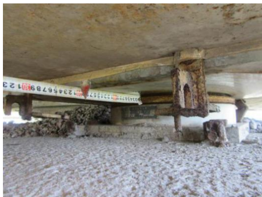
图 A.1.2-11 A 匝道 22#墩支座滑移 19.3cm
