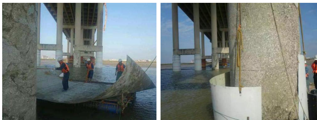
图 3.6.3-2 玻纤套筒吊装就位
