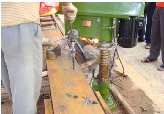
图 3.1.3-2 钢板表面钻孔
