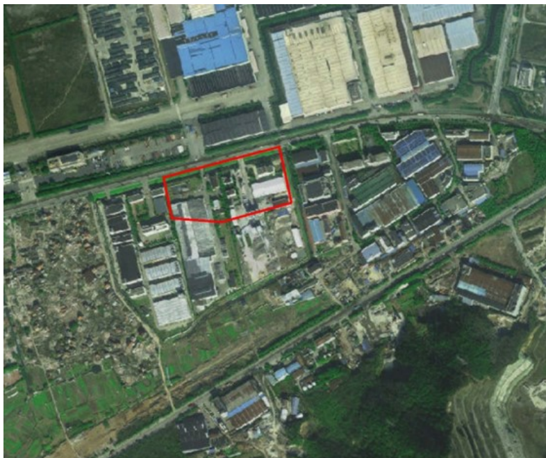
图4-21 青峙化工园区危化品停车场现状用地图
