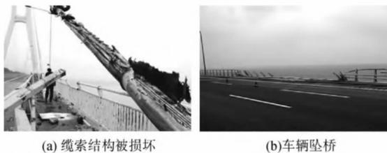
图 2 护栏防护效果不佳,导致车辆碰撞缆索及坠桥事故
