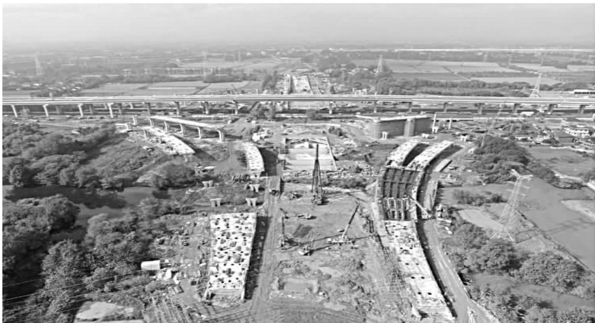
速度 60 千米/小时。下部结构采用桩基础、承台、花瓶墩等，上部结构形式采用预应力混凝土现浇箱梁、普通钢筋混凝土现浇箱梁、钢混组合梁。
