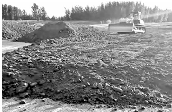
图 2 铁矿渣路基填料摊铺整平
