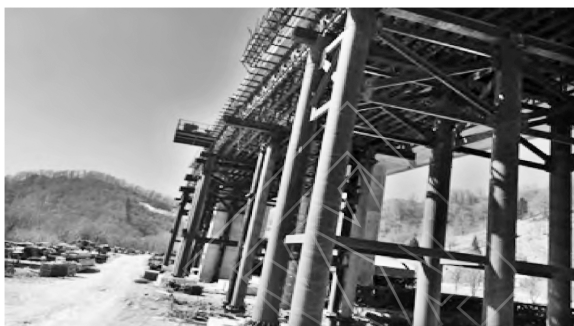
图 2 钢管桩支架结构形式
