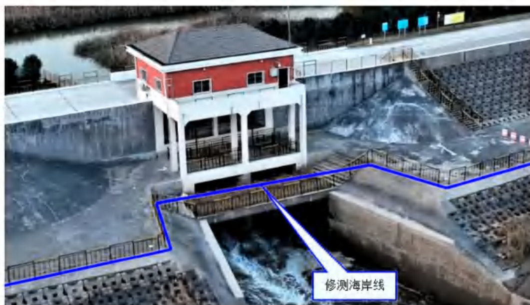
图 2.1-6b 现状照片（黄沙坞排涝闸）
