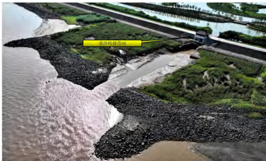
图 2.1-6a 现状照片（黄沙坞排涝闸）
