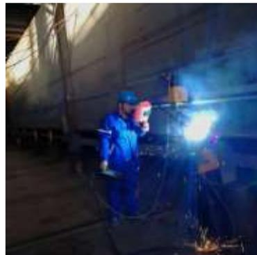
钢箱梁总拼便携式机器人焊接系统
