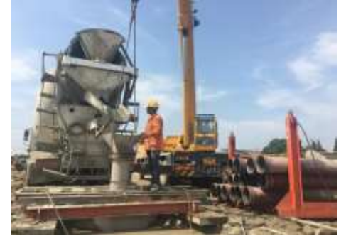
混凝土灌注架
