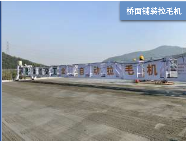
桥面铺装摊铺机
