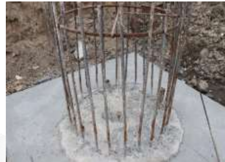
桩头钢筋调整
