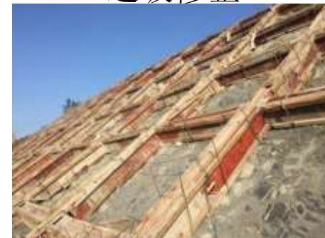
框格梁模板限拉顶结合
