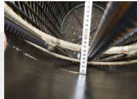
墩身钢筋保护层检测
