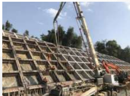
混凝土浇筑
