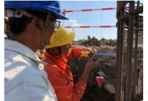
钢筋笼垂直度检测
