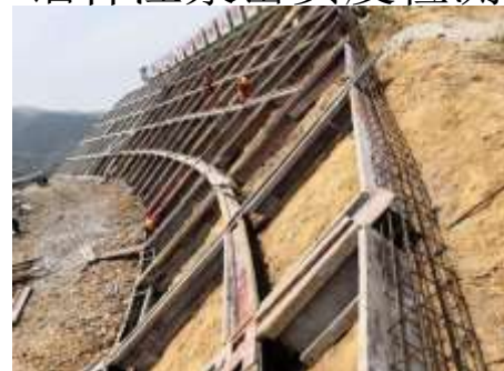
钢筋模板安装
