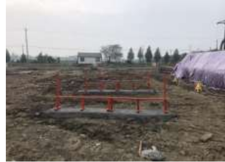
钢筋笼存放架
