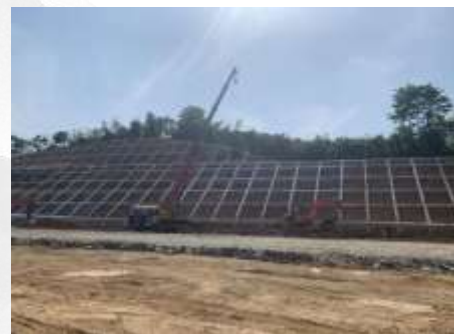
框格梁成型现场照片
