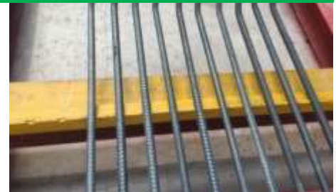
定位骨架间距水平胎架
