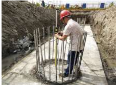
墩柱中心点位放样
