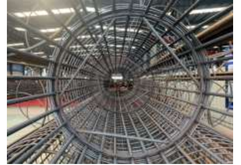
钢筋笼防变形三角支撑
