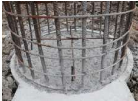
模板定位钢筋
