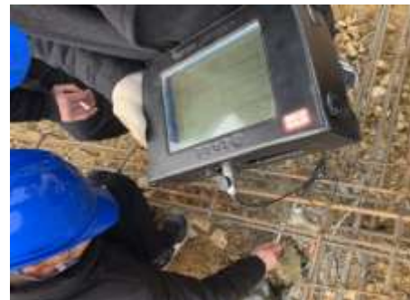
锚杆注浆密实度检测
