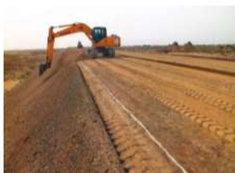
路基填筑边坡
