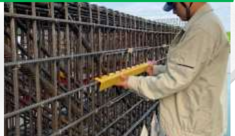
定位水平钢筋间距胎架
