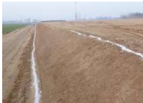
路堤填筑边线
