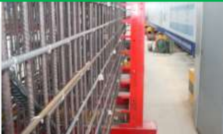
定位水平钢筋间距胎架
