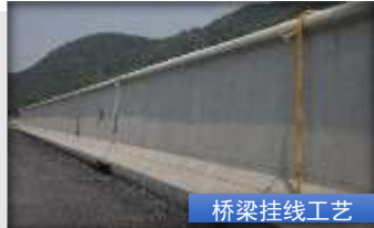
桥梁挂线工艺
