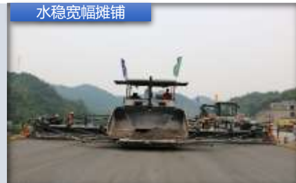
水稳宽幅摊铺
