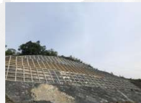
框格梁成型现场照片
