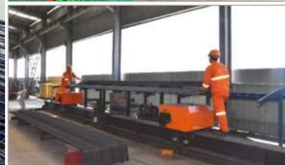
工厂化钢筋加工
