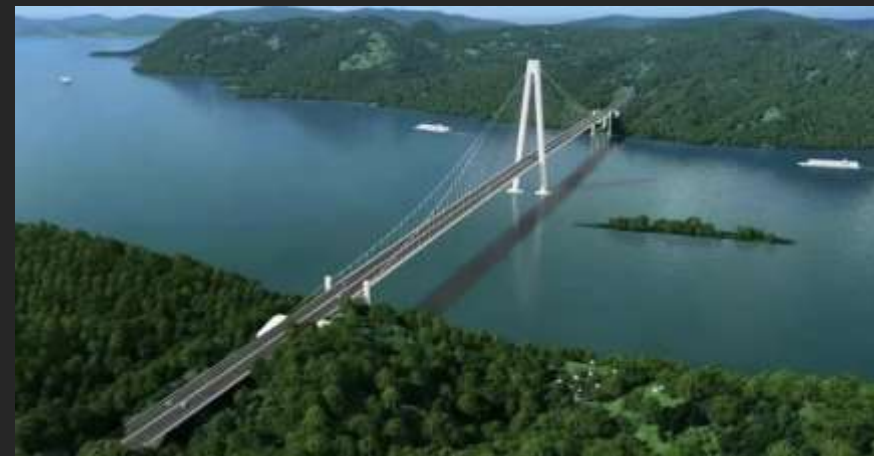
平南至岑溪北段公路滕州浍江大桥
