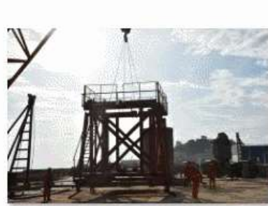
2、工艺工序 吊装导向架 魏宗浩
