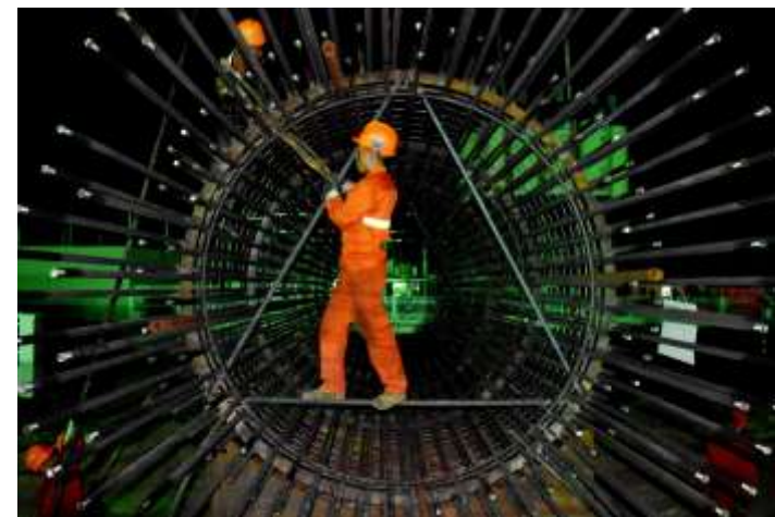
大直径 \phi 3.0 钢筋笼制造
