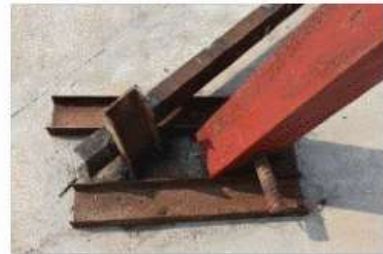
4、钢护筒导向架加固 (周国林)
