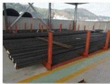
2、钢筋厂材料进场
