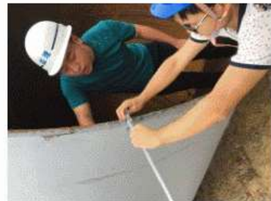
7、钢护筒壁厚检查
