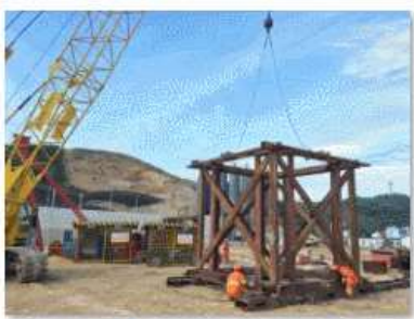
1、北塔桩基钢护筒导向架加工 (周国林)
