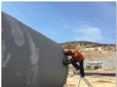
8、钢护筒焊接吊耳 (周国林)
