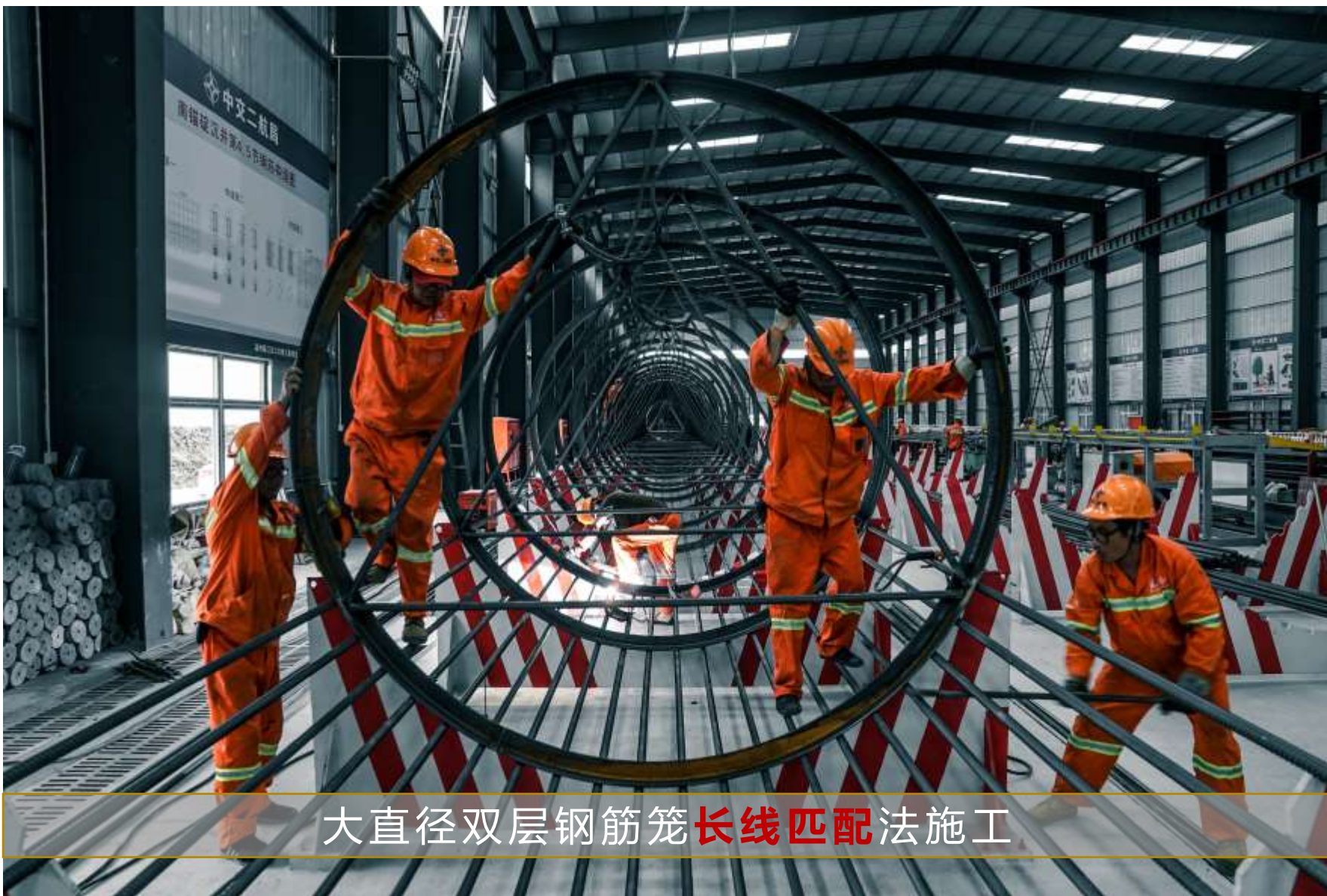
大直径 \phi 3.0 钢筋笼制造
