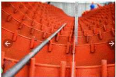
3、钢筋笼加工台验收 (长线匹配)
