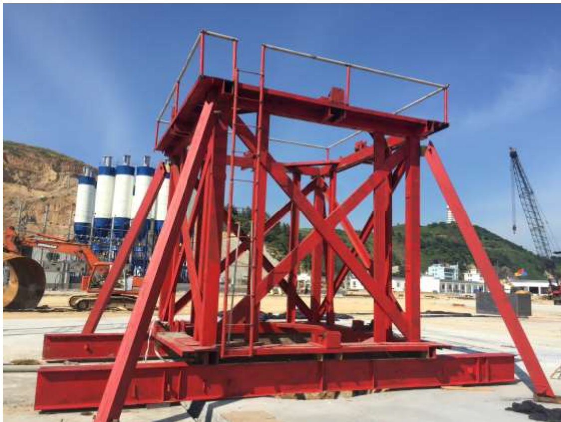
多点联动式导向架
