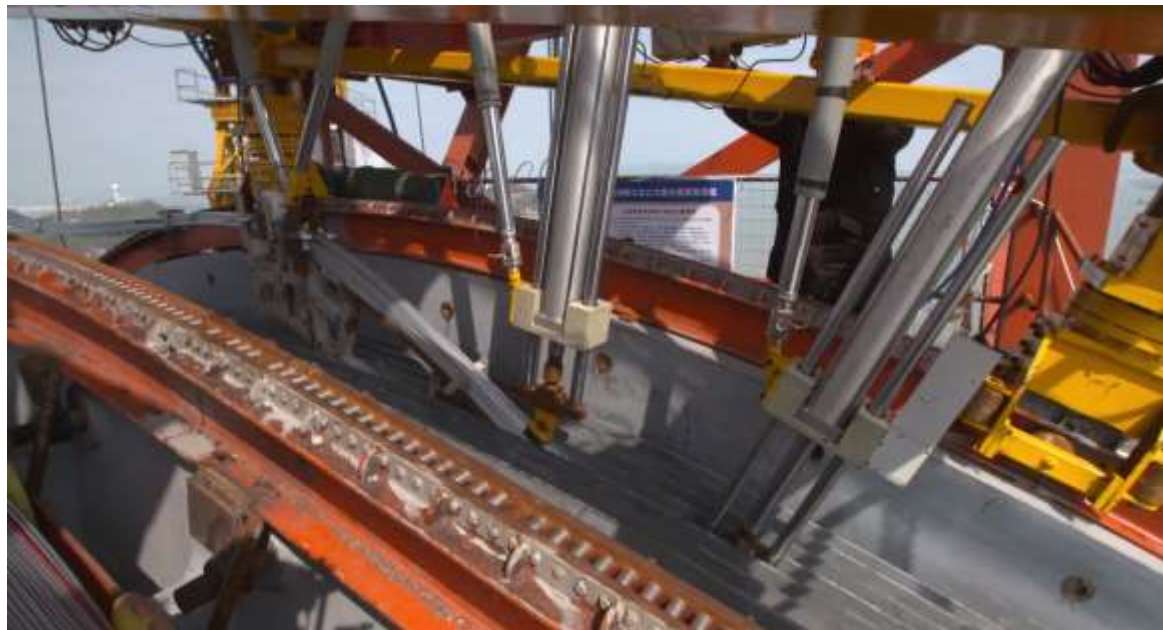
主缆深槽入鞍施工 智能入鞍机器人
