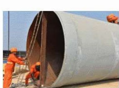
9、钢护筒孔口加固 (周国林)
