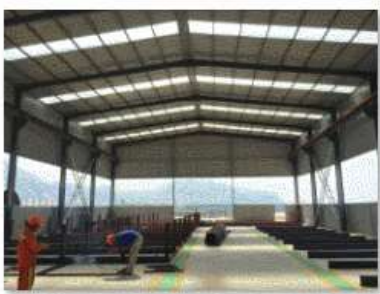
1、钢筋厂钢筋台架加工
