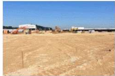
4、场地平整桩位放样
