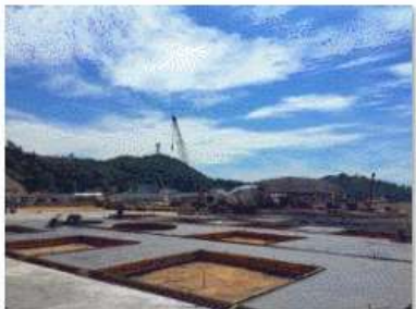
5、钻孔平台场地硬化
