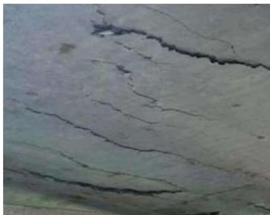
底板的局部崩裂破坏
