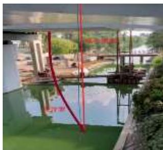
以江东大桥为例，采集467520张照片，其中混凝土梁底病害图像3896张，涵盖裂缝、剥落、风化、露筋等各类病害，病害识别率90%以上。
