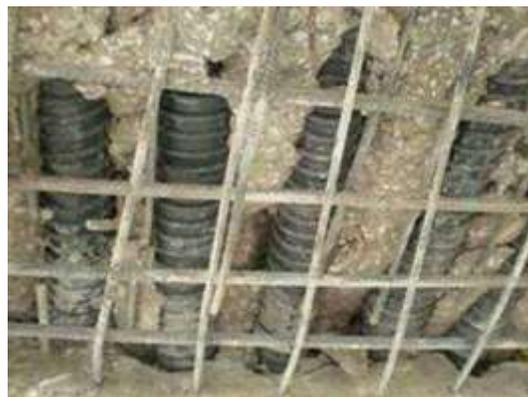
箱梁底板撕裂破坏
