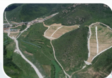
水土保持工程
