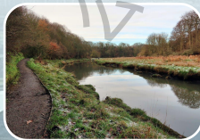
自然岸线修复工程
