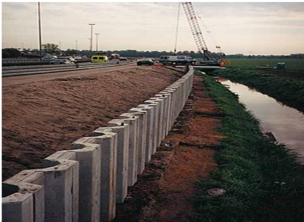
图 6.3.1 先张法 U 形预应力混凝土板桩挡墙实景图（尚未浇筑帽梁）
