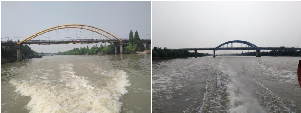
图 6.4.4 桥梁现状图片二（基础与护岸的距离）
