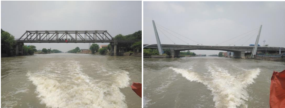
图 6.4.3 桥梁现状图片一（基础类型）
