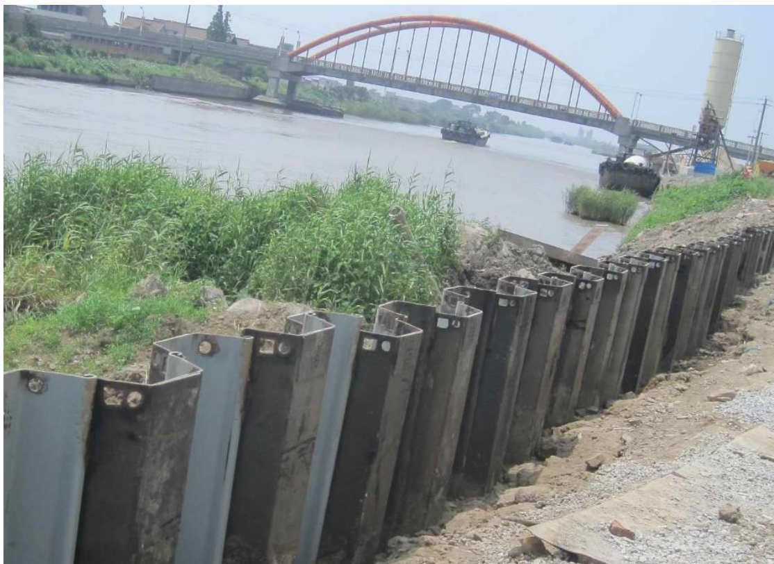
图 6.3.3 U 型钢板桩挡墙实景图（尚未浇筑帽梁）
