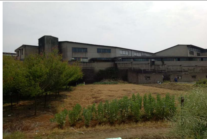
南面（建设用地）
