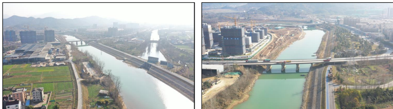
图 3.8 壶源溪场口段照片
