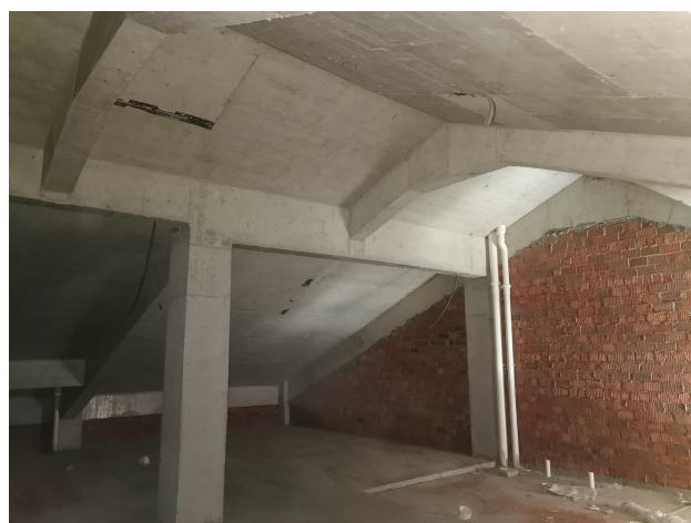
图 4、屋顶阁楼增做的地面楼板
