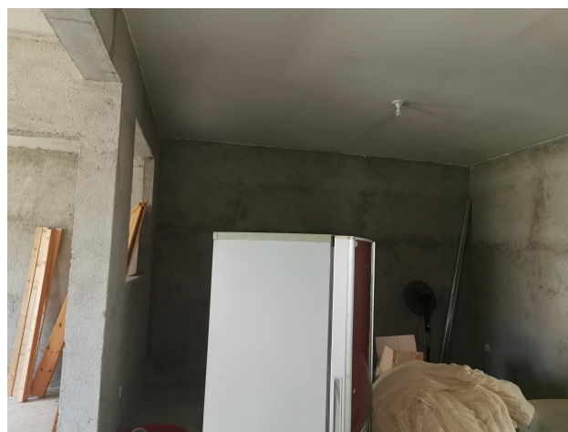
图 8、楼层内部照片
