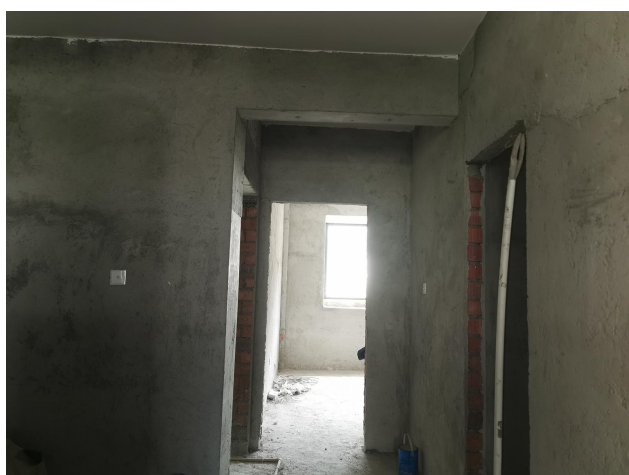
图 5、楼层内部照片
