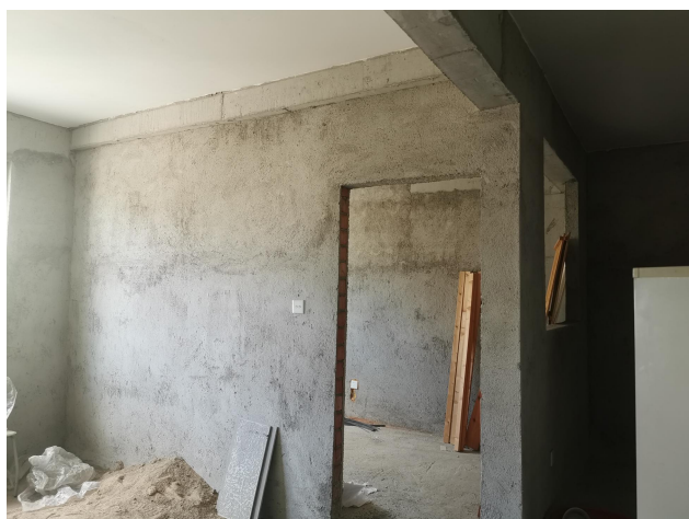
图 7、楼层内部照片
