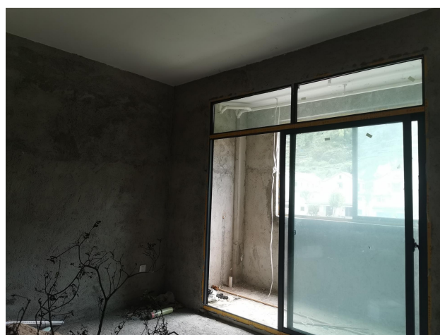
图 6、楼层内部照片
