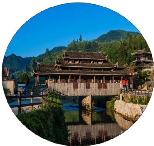
西一村汇集宋明清三代建筑，有“寺祠院三观同址，宋明清三代同堂，儒释道三教合流，古寺、古树、古桥三古同辉”的美誉
