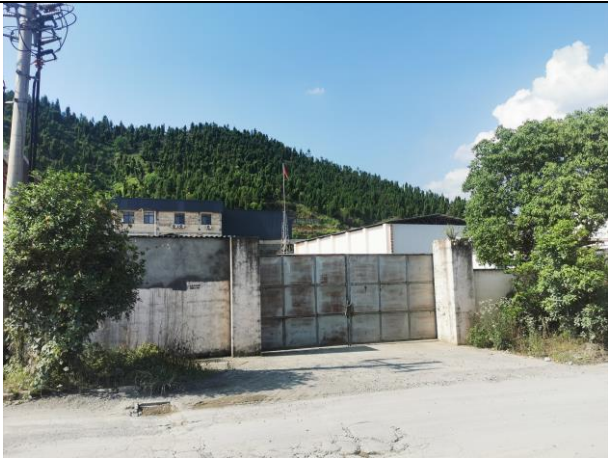
现状衢盛化工大门
