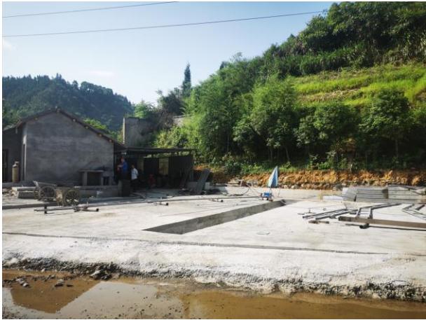
现状江松混凝土车辆检修场
