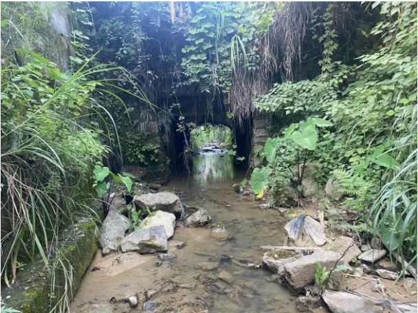
现状涵洞北侧（尺寸约 2.9*2.9）
