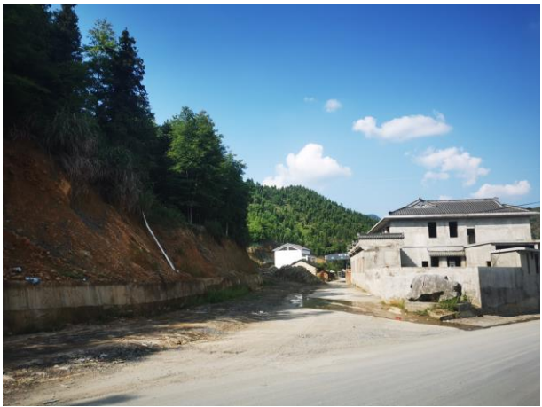
现状山上雨水散排至路面
