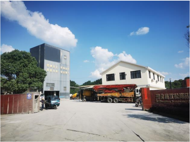
现状江松混凝土厂区大门
