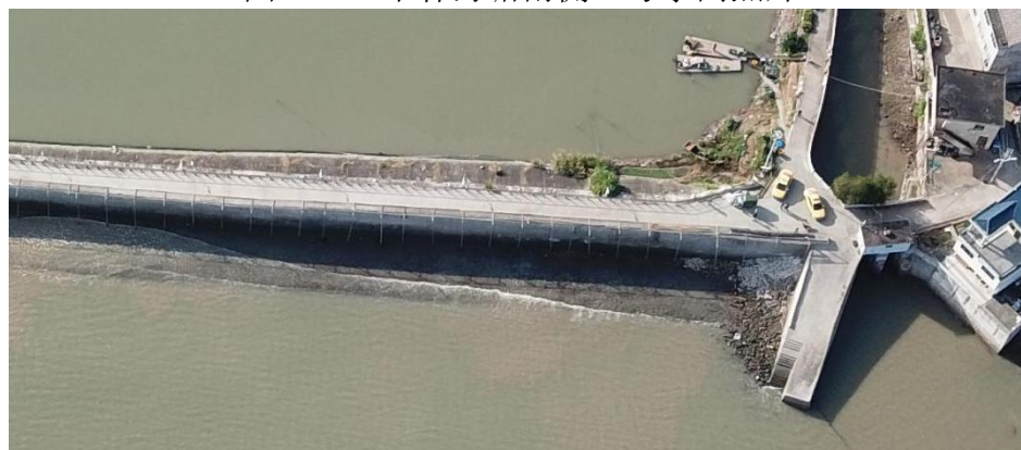
图 2.1-4d 1 号水闸及现状海塘堤顶现状照片
