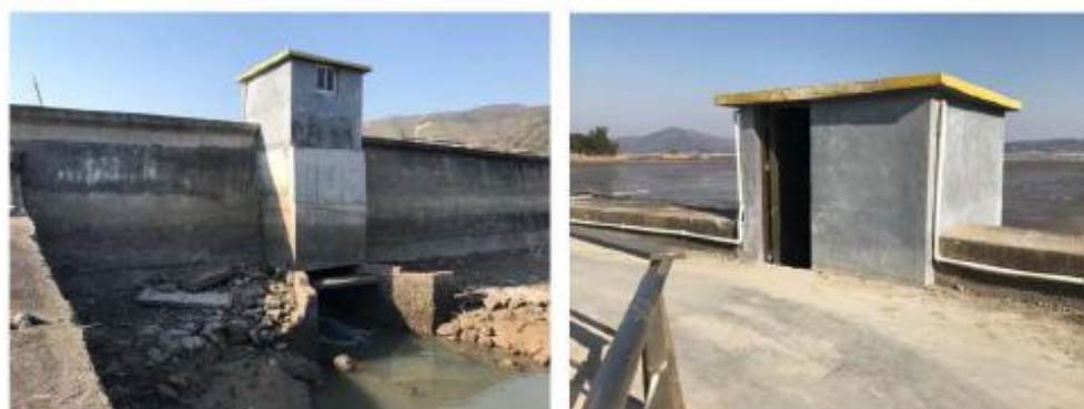
图 2.1-4b 木林海塘中间 2 号水闸照片
