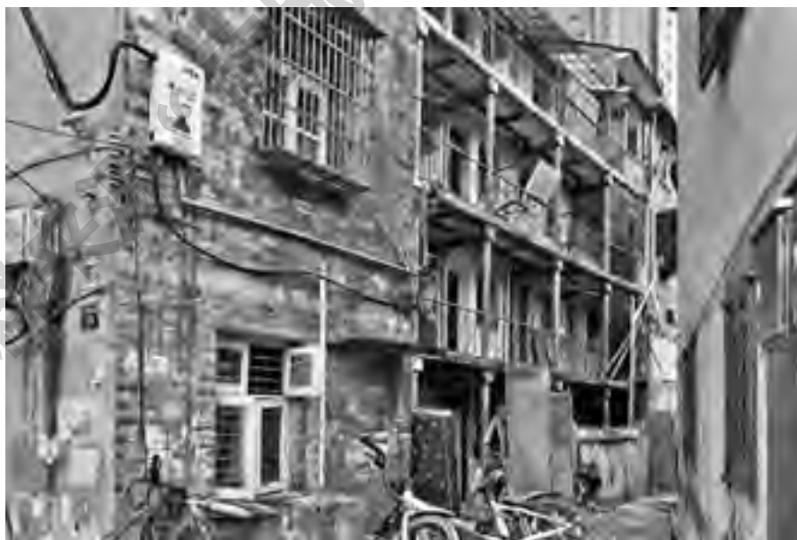
正在拆除的九柏园头老房子。
