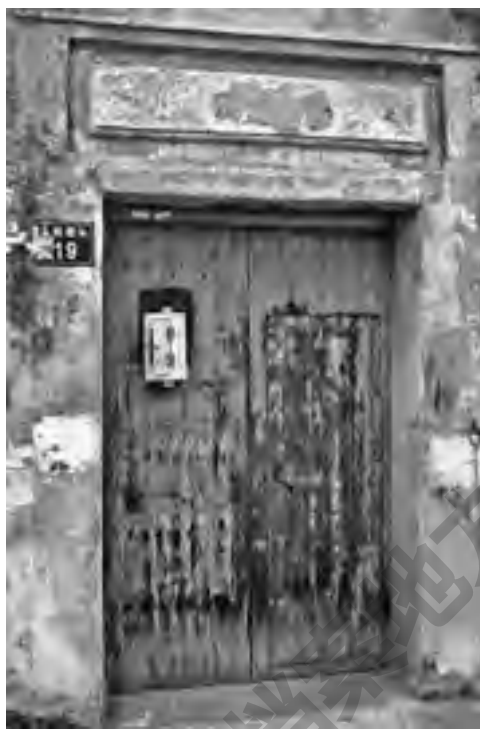
待拆建的九柏园 头小巷。
