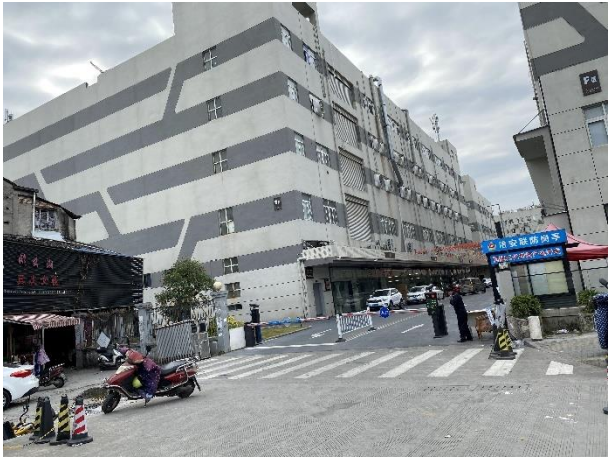
现状尚吉路工厂出入口
