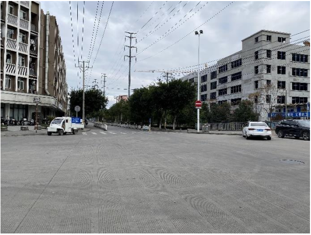
现状尚吉路与富伊路交叉口
