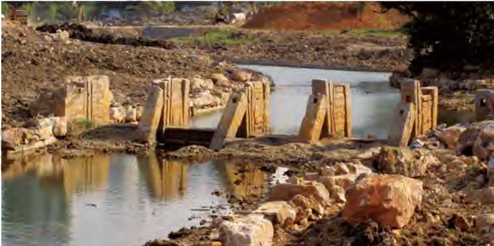
下埭门南宋水闸遗址。
