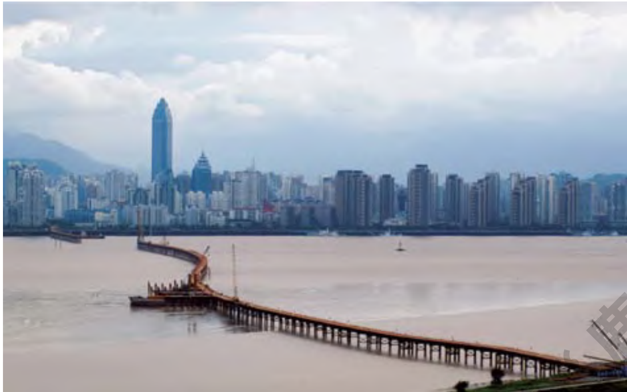
建设中的温州过江通道。
