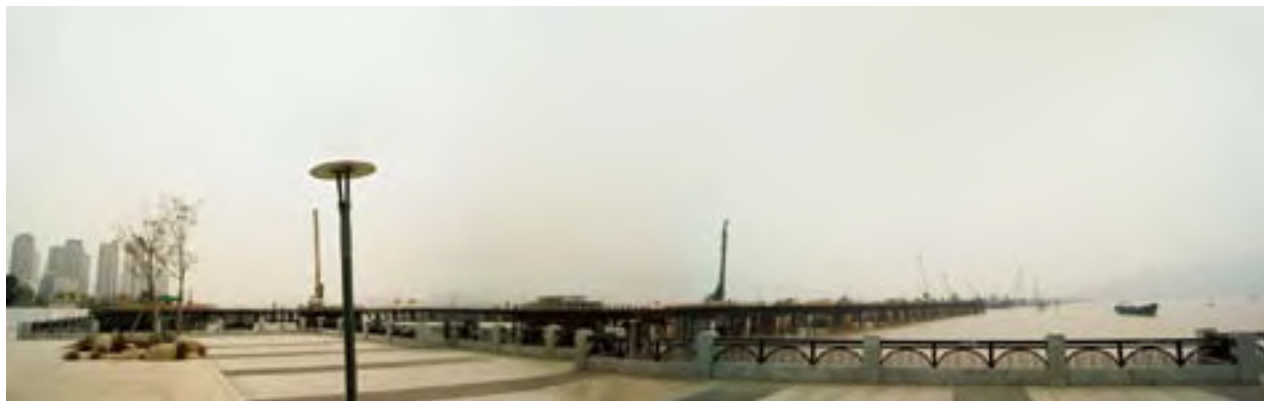
11月,诸永高速公路温州段延伸工程施工现场。
