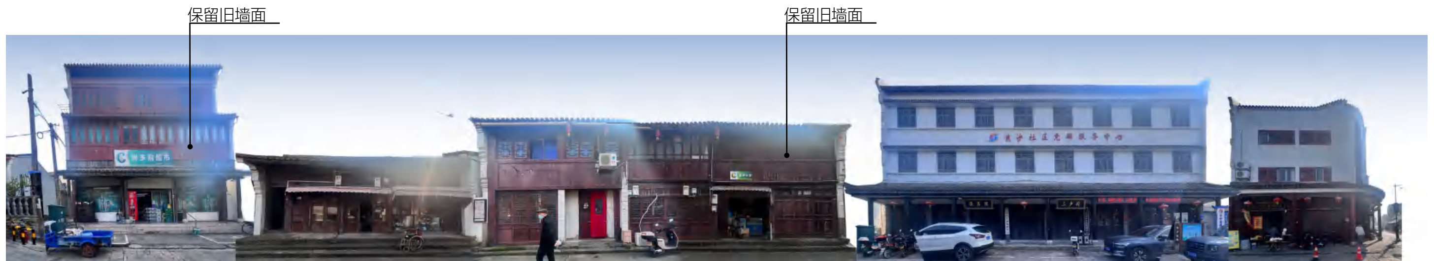
和平路南侧 - 改造前
