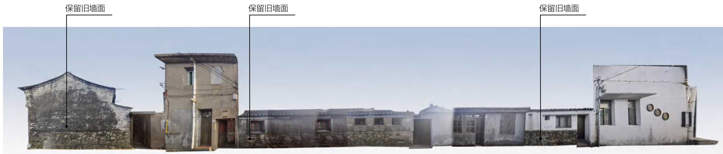
争取弄南侧 - 改造前
