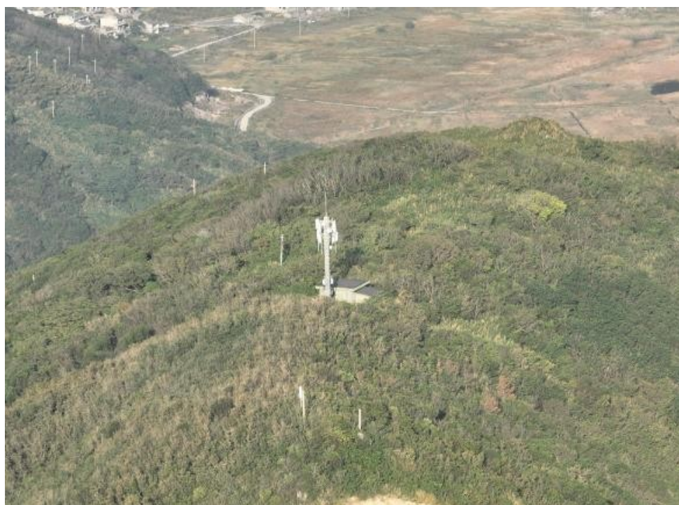
图2-6 北侧山顶通讯塔及基站
