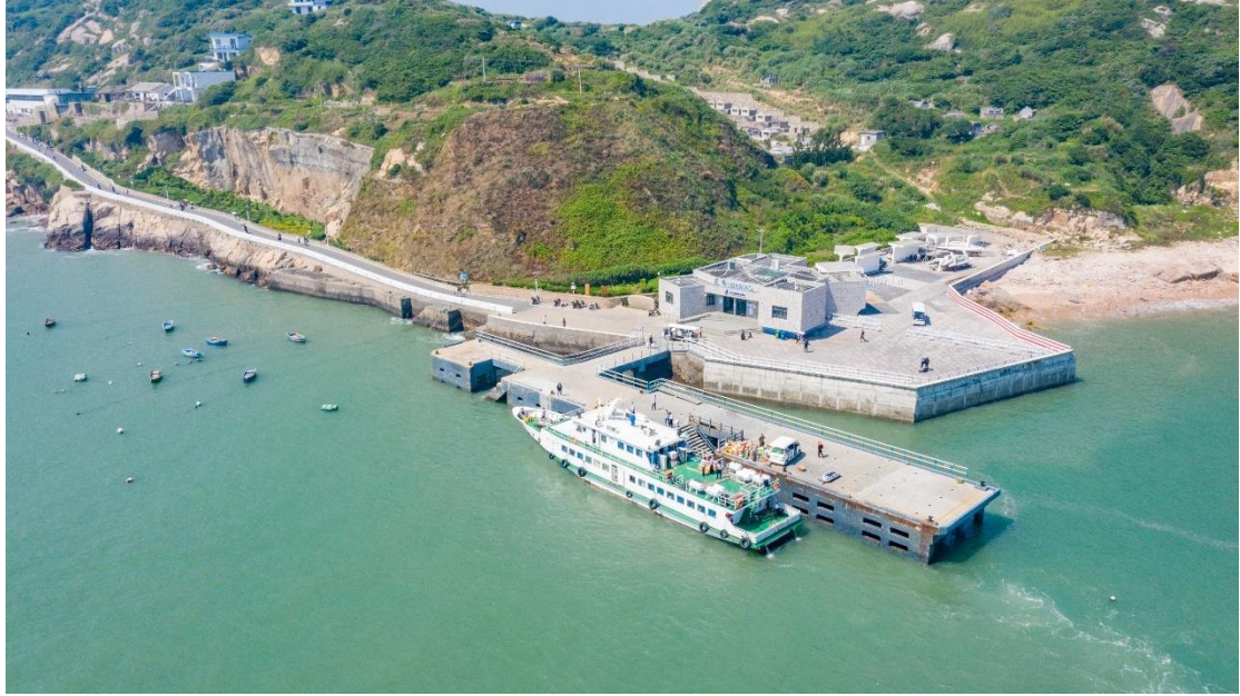
图 1.1-2 现状南岙客运码头（客运站拆除前）
