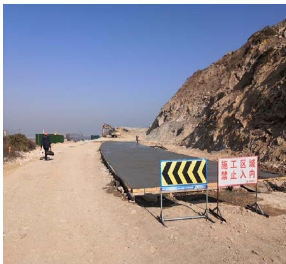
项目区南侧在建 G526 国道（1）
