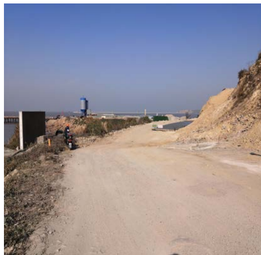
项目区南侧在建 G526 国道（2）
