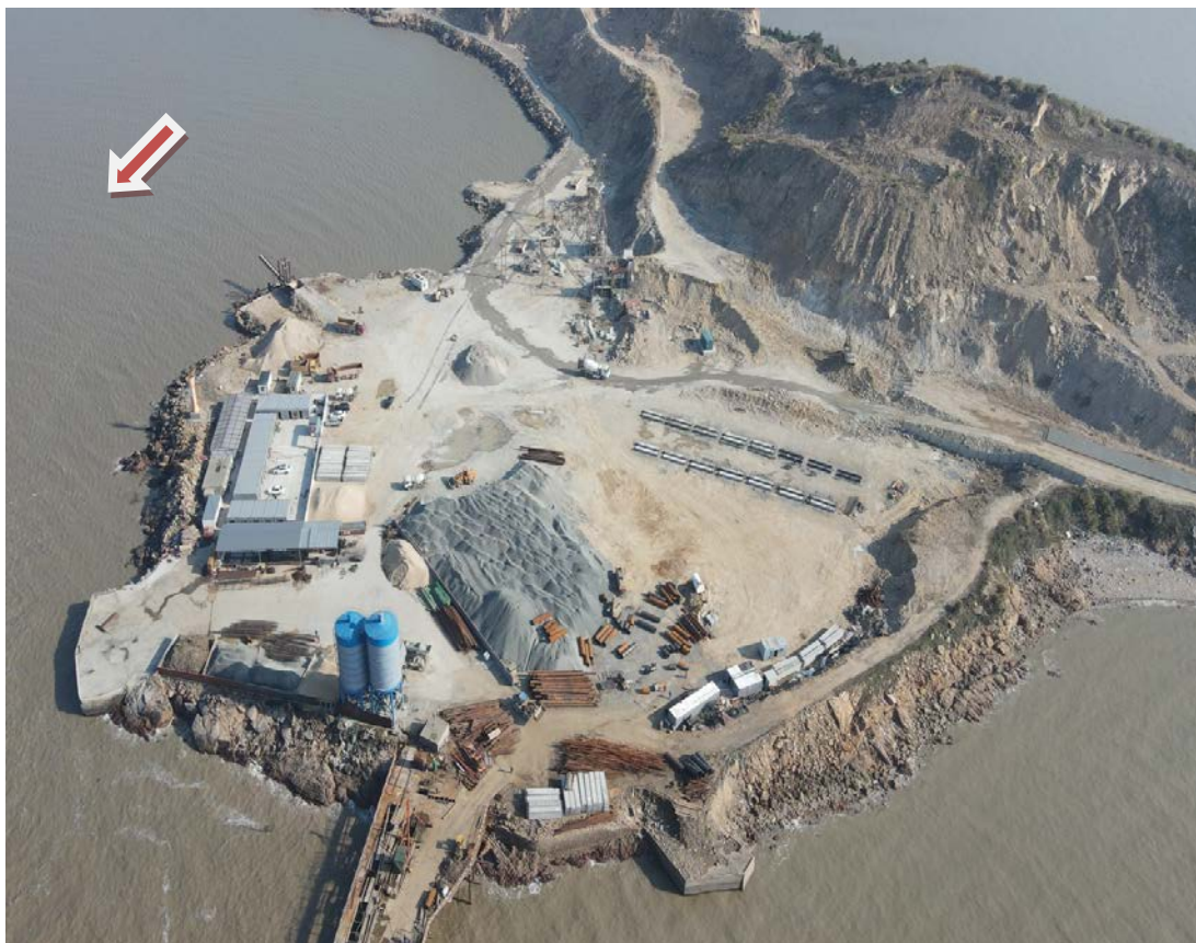
项目区场地自西北向东南现状
