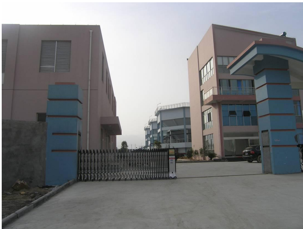
图 4.3-1 滨海园区第二污水处理厂照片
