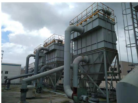
固废破碎系统废气处理设施
