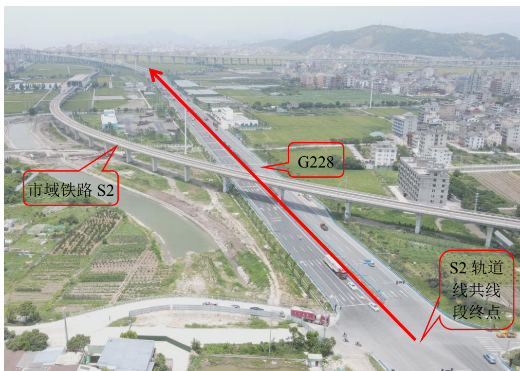
图 2.3-3 G228 建设现状照片
