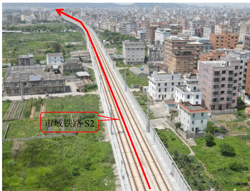
图 2.3-2 市域铁路 S2 建设现状照片
