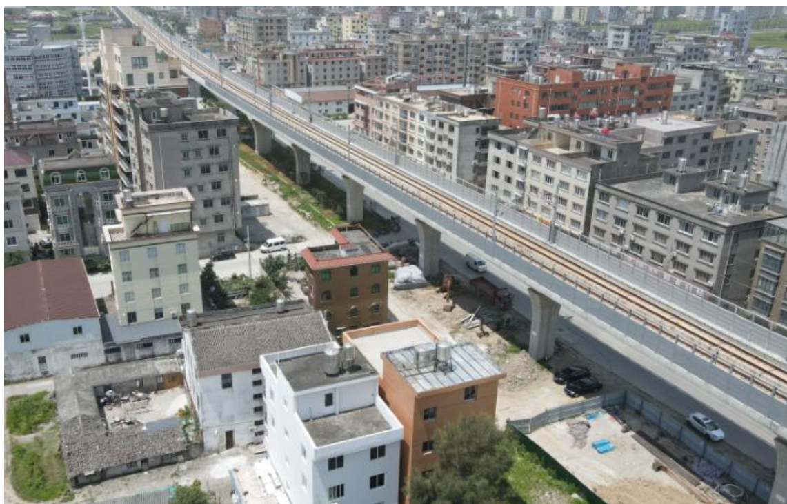
图 5.3-1 市域铁路 S2 声屏障设置现状图
