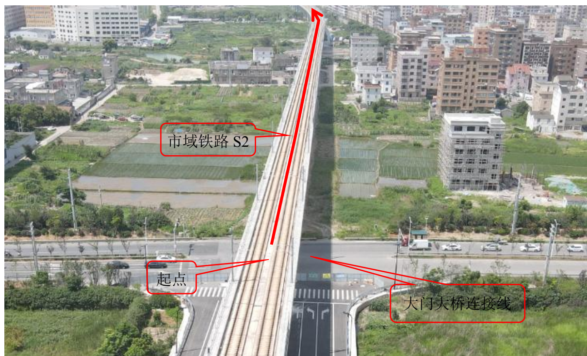
图 2.3-1 项目起点位置现状照片
