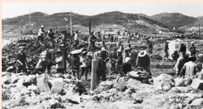
1977年,定海电厂建设场景
