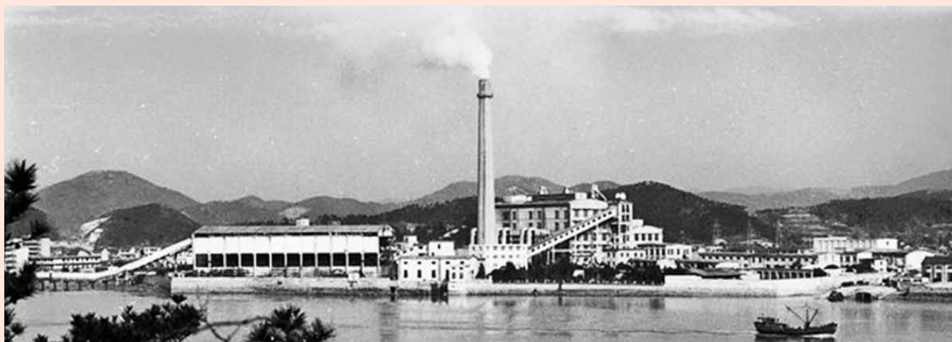
1979年,定海电厂一期第一台1.2万千瓦发电机组试运行成功
