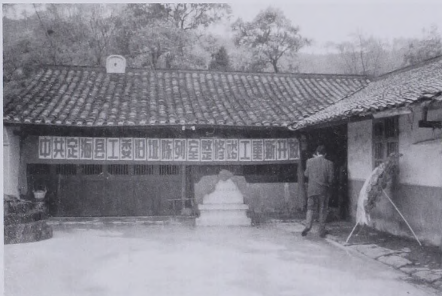
△中共定海县工委旧址
