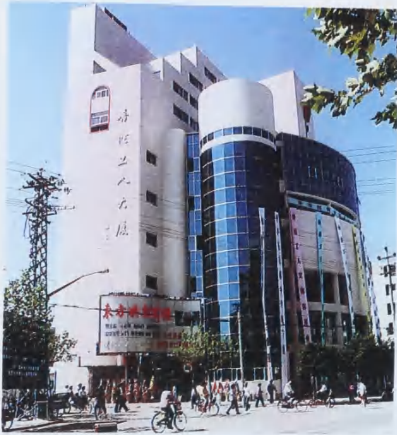
新建的普陀工人大厦
