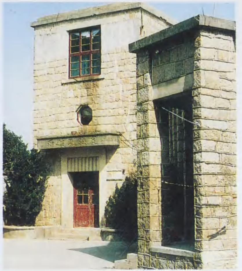
1936 年建的定海测候所
