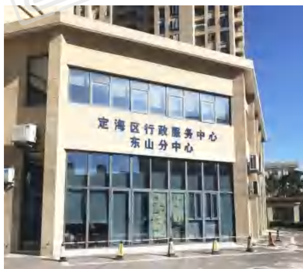
区行政服务中心东山分中心大楼
