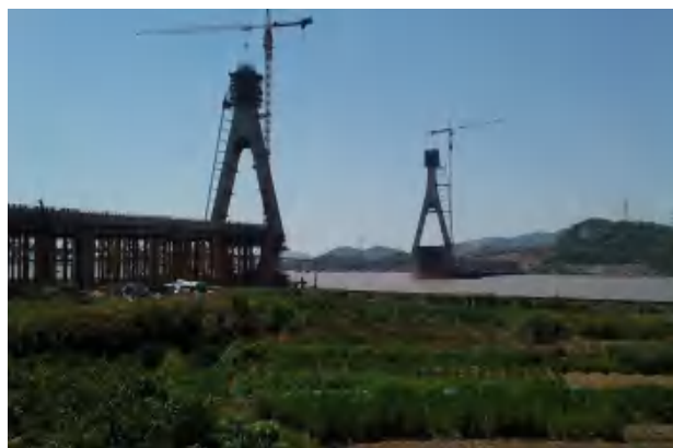
建设中的富翅门大桥
