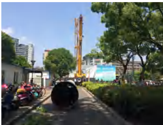
定海东门交通综合体附近高杆广告拆除
