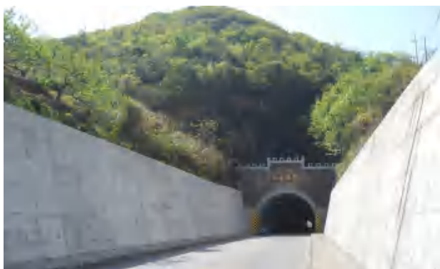
维修改造后的小岭隧道
