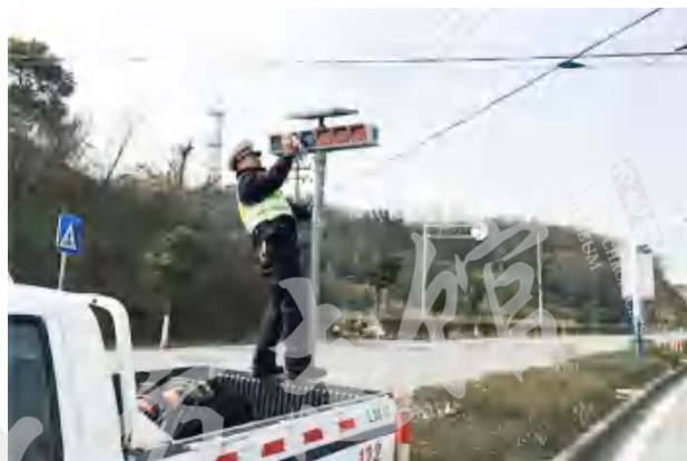
民警在329国道安装爆闪灯
