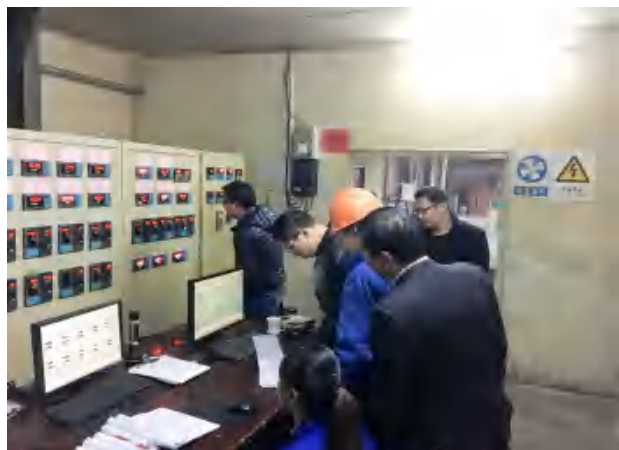
2017年3月，化工企业安全生产检查
