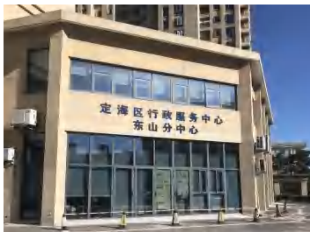
区行政服务中心东山分中心大楼
