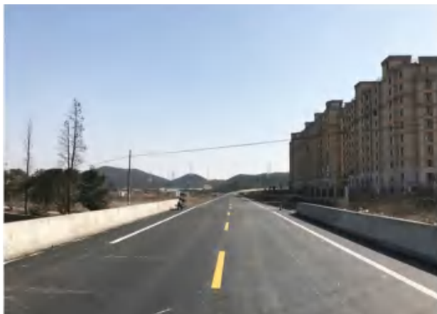
小沙至白泉公路Ⅱ标段工程
