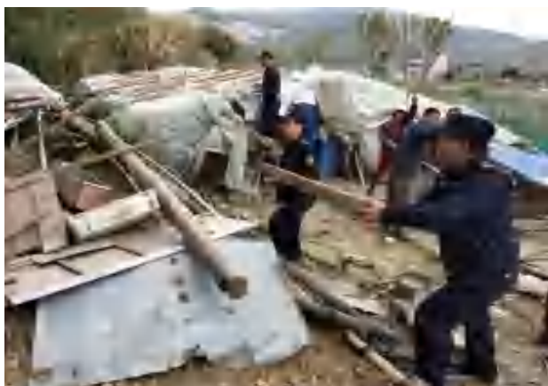
拆除违章建筑
