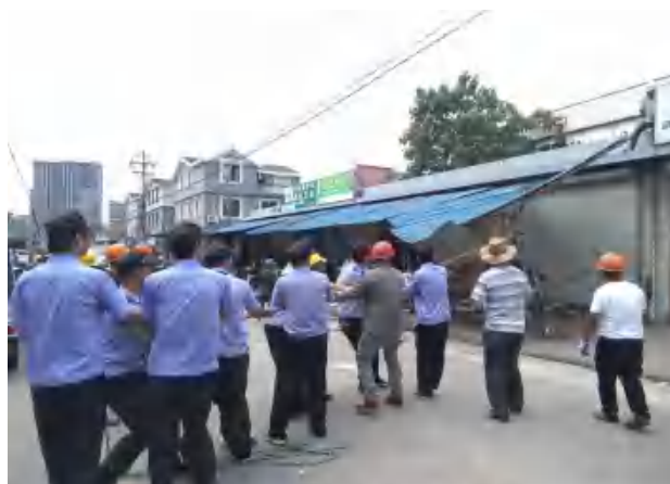
拆除违法建筑
