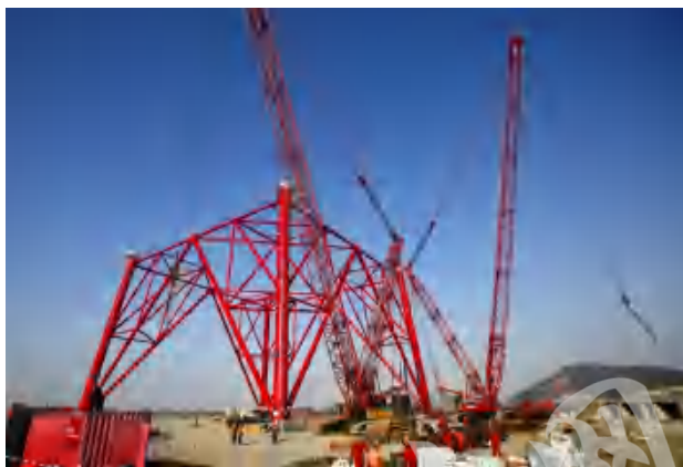
樟树岙段380米输电铁塔组立现场
