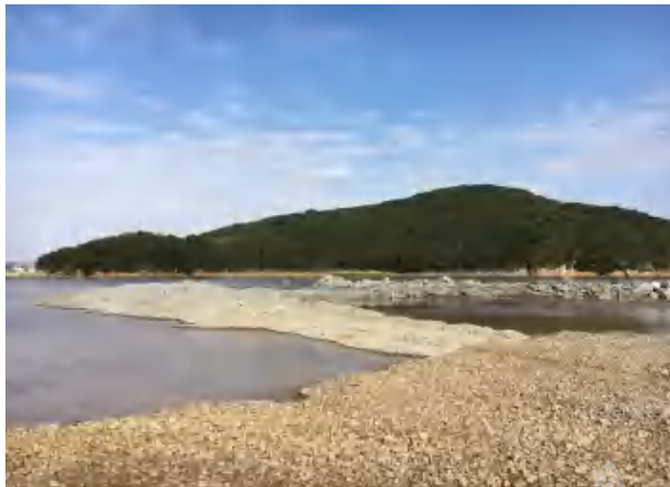
西码头中心渔港扩建工程护岸及回填项目
