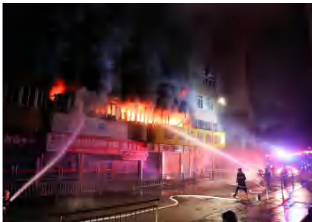
2月18日，东海西路店面火灾现场
