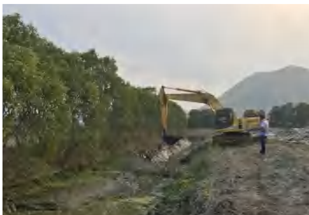
三星社区“早改水”质量提升项目施工现场
