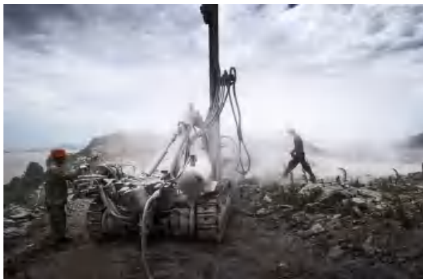
中澳现代产业园建设现场
