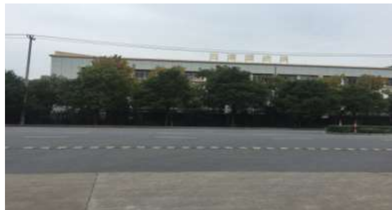
项目地南面（启圣路，隔路为绍兴市鑫北纺织品有限公司和浙江福欣德机械有限公司）
