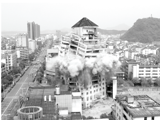
临安电力大厦被成功爆破拆除
