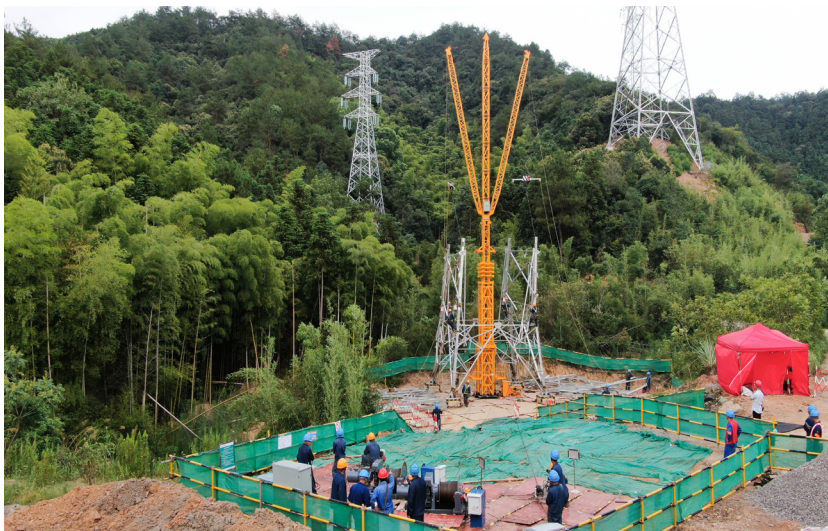
图 131 2022年8月30日,区供电公司完成杭州市首次座地摇臂抱杆组立铁塔新工法试点工作(区供电局 提供)
