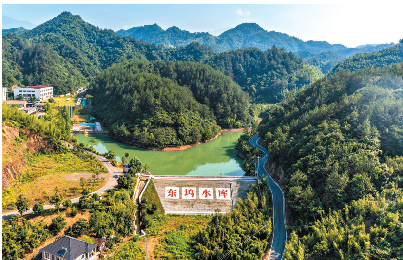
图 129 除险加固后的东坞水库（摄于 2022 年，区水利水电局 提供）
