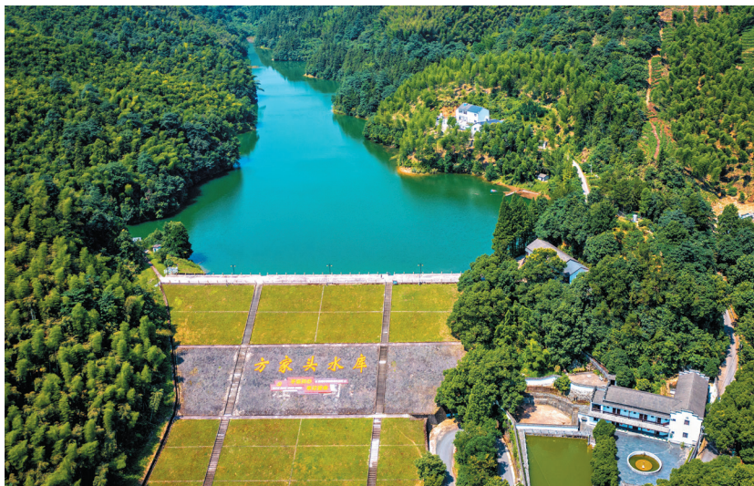
图 130 除险加固后的方家头水库（摄于 2022 年，区水利水电局 提供）
