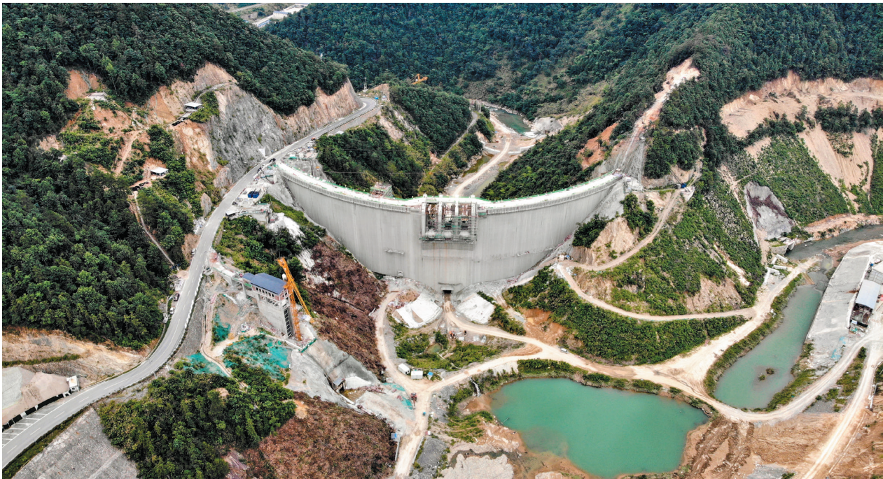
图 127 建设中的双溪口水库（摄于 2022 年，区水利水电局 提供）
