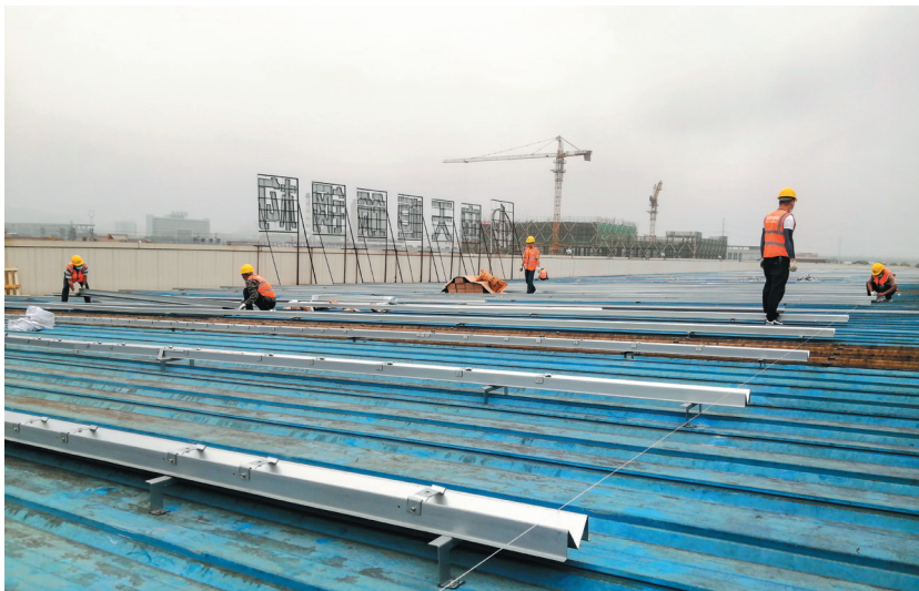
图 132 2022年4月30日,临安首个高压并网光伏项目——中天恒筑钢结构有限公司6.2兆瓦屋顶分布式光伏发电项目开工建设(毛於峰 摄)
