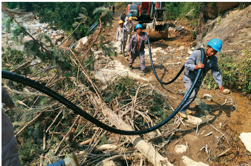
图 205 2019年8月13日, 区供电公司人员铺设临时供电线路
