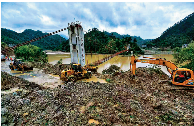
图 194 2019年8月11日,区交通运输局组织力量抢通330国道龙岗至岛石段
