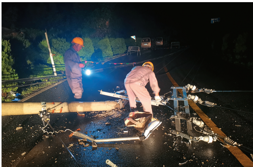
图 203 2019年8月11日, 区供电公司人员抢修被台风损毁的电力设施
