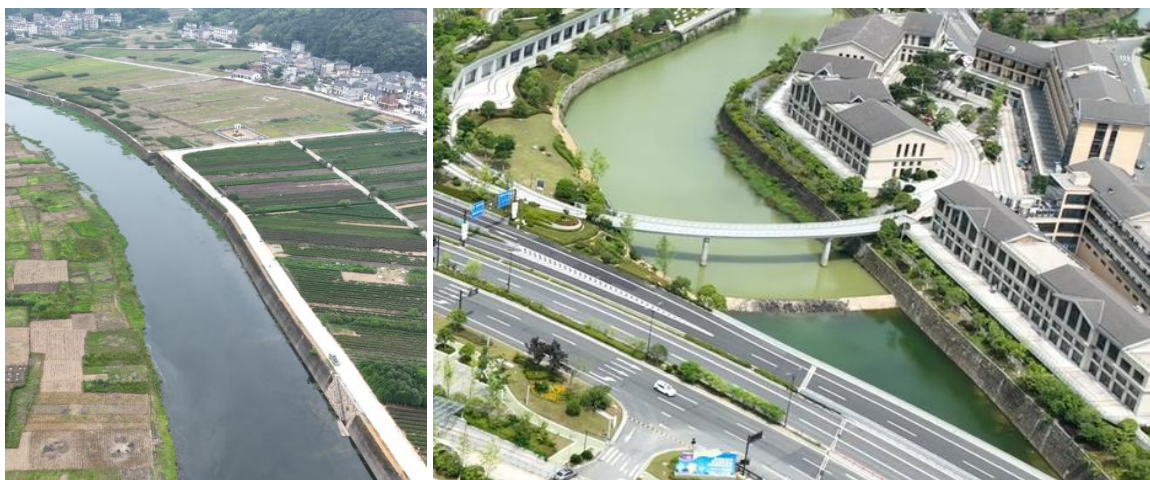
图 2.13 护岸现场照片
