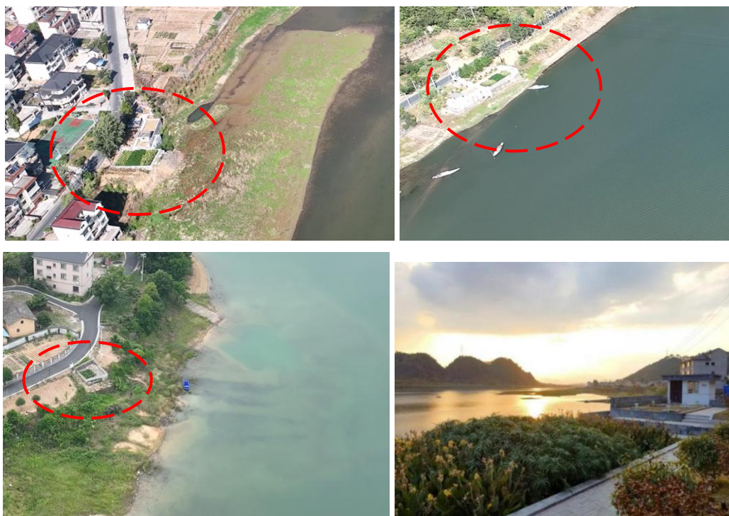
图 2.8 环湖农村分散污水处理设施照片
