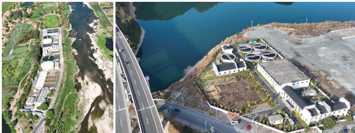
图 2.7 环湖城镇集中污水处理厂航拍照片
