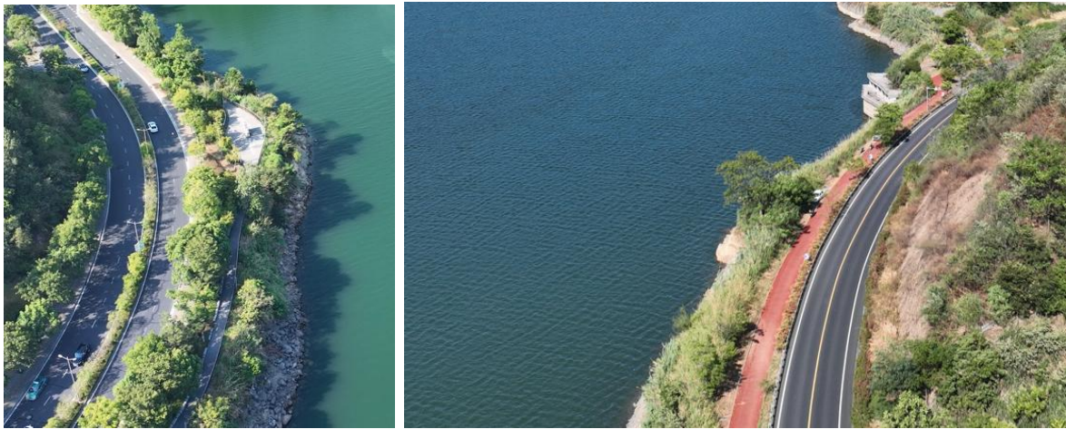
图 2.14 环湖道路现场照片
