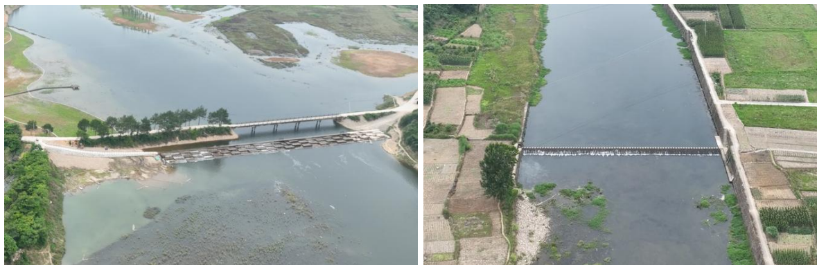
图 2.11 堰坝现场照片
