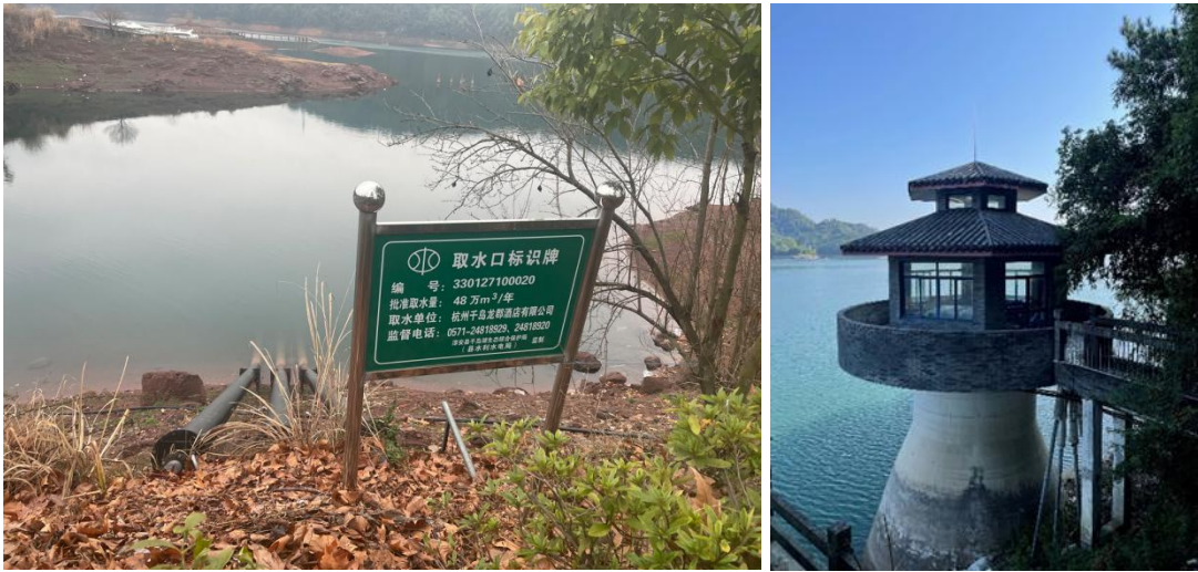
图 2.10 环湖岸线取水口设施
