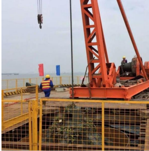
图 3.2.4-29 冲击钻成孔示例图
