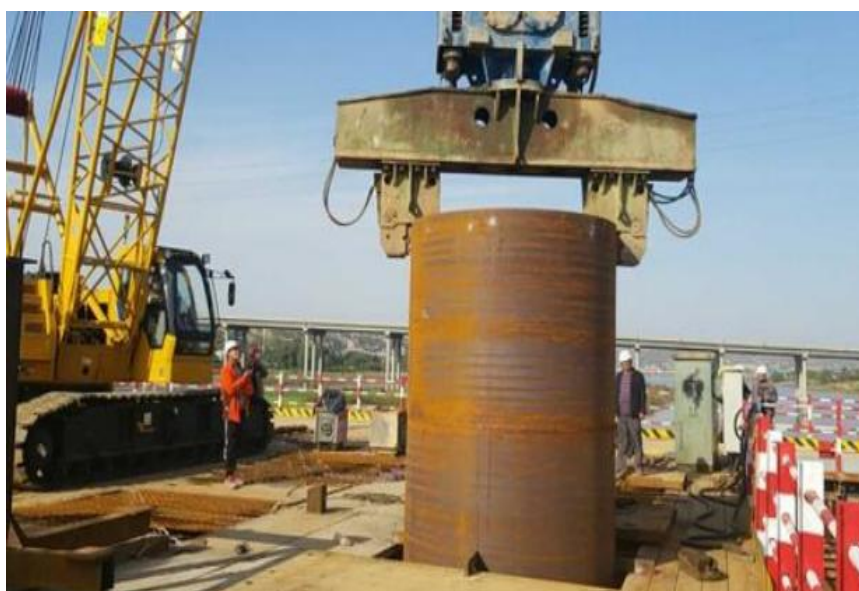
图 3.2.4-28 钢护筒施打示例图
