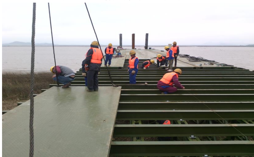
图 3.2.4-21 桥面系安装实例示意图
