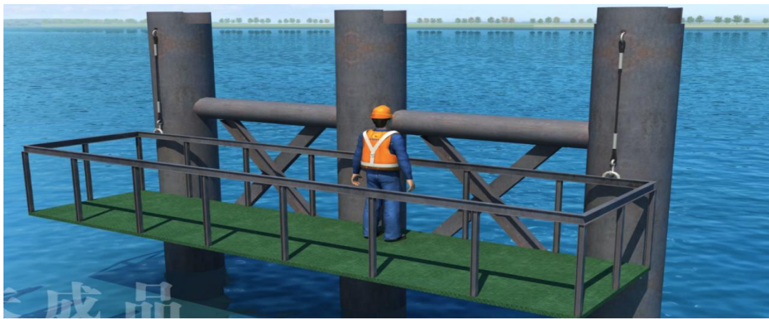
图 3.2.4-17 平联剪刀撑施工示意图
