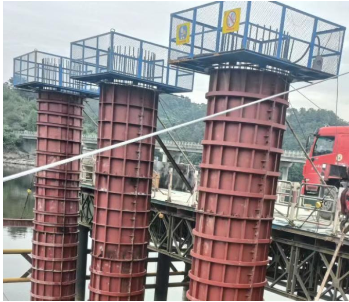
图 3.2.4-35 砼振捣平台示例
