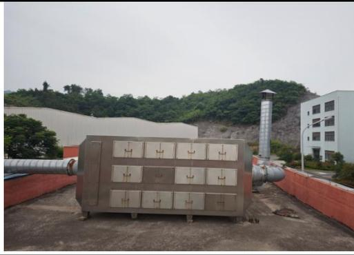
溶剂涂料检测楼废气处理设施：活性炭吸附
