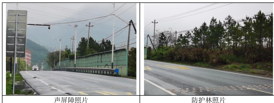
图 3-5 原有公路声屏障和防护林照片
