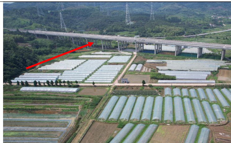
项目区内现状航拍图（八）
