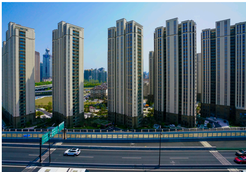
交付使用的印铁地块安置房(2018年)
