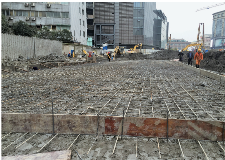
2019年2月26日，工联二期项目完成马路钢筋施工
