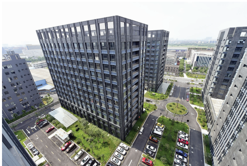
电子机械功能区建筑面积10万平方米标准厂房 (区电子机械功能区 供稿)
