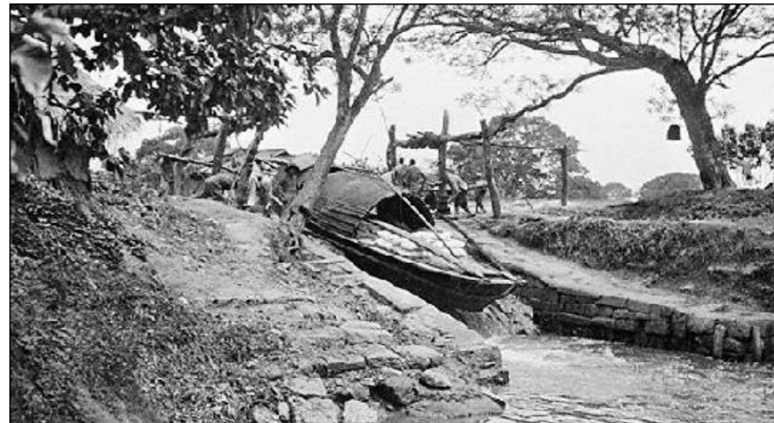
1970 年拆毁的杭州德胜坝，就是这样的河坝，用以隔断南北两侧河道的水
