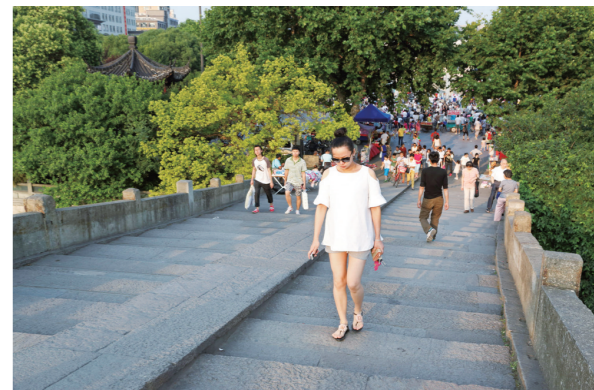
▲ 轻纺大桥和登云桥的建成，让这座古桥终于减轻了负担。图为2004年6月2日，走上这座拱桥的多半是游人。
