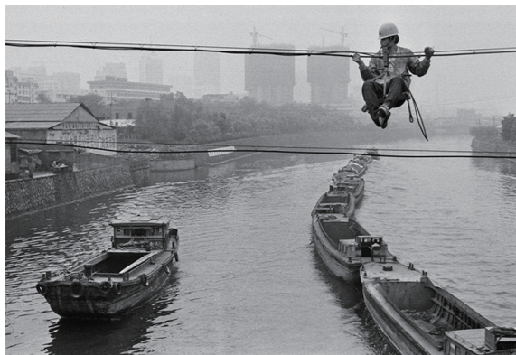
▲ 1995年4月5日，一工人在大运河杭州艮山门段检修线路。
